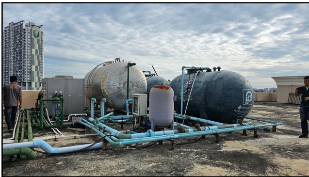
ถังเก็บน้ำขึ้นดาดฟ้าแต่ละอาคาร (ถังน้ำเย็น) ขนาด 12 ลบ.ม จำนวน 2 ถัง (รวม 24 ลบ.ม.) และถังน้ำร้อนขนาด 10 ลบ.ม. รวมถังเก็บน้ำดาดฟ้า 34 ลบ.ม. /อาคาร
