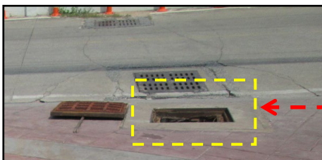
จุดที่ 4 บ่อตรวจก่อนปล่อยออกสู่ ท่อระบายน้ำสาธารณะ
