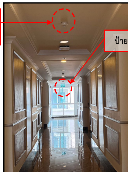
เครื่องตรวจจับควัน (Smoke Detector)
