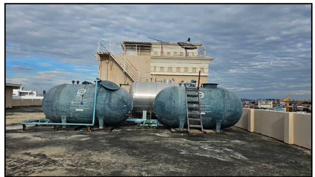
ถังเก็บน้ำขึ้นดาดฟ้าแต่ละอาคาร (ถังน้ำเย็น) ขนาด 12 ลบ.ม จำนวน 2 ถัง (รวม 24 ลบ.ม.) และถังน้ำร้อนขนาด 10 ลบ.ม. รวมถังเก็บน้ำดาดฟ้า 34 ลบ.ม. /อาคาร
